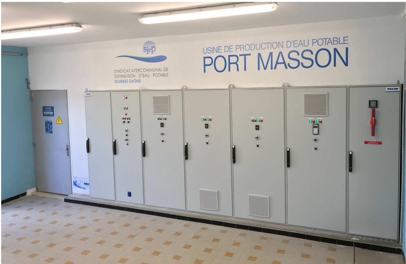
*Travaux 2017 – sécurisation de la ressource de Port Masson : doublement des pompes des puits et de la pompe de reprise 400 m<sup>3</sup>/h, remplacement et amélioration des armoires électriques, essais de pompe longue durée dans le cadre de la révision de la DUP*
